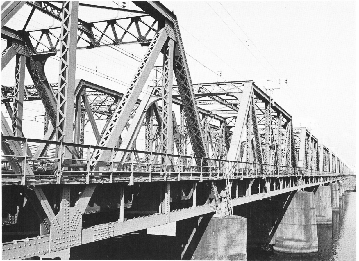
上淀川橋梁下り線
