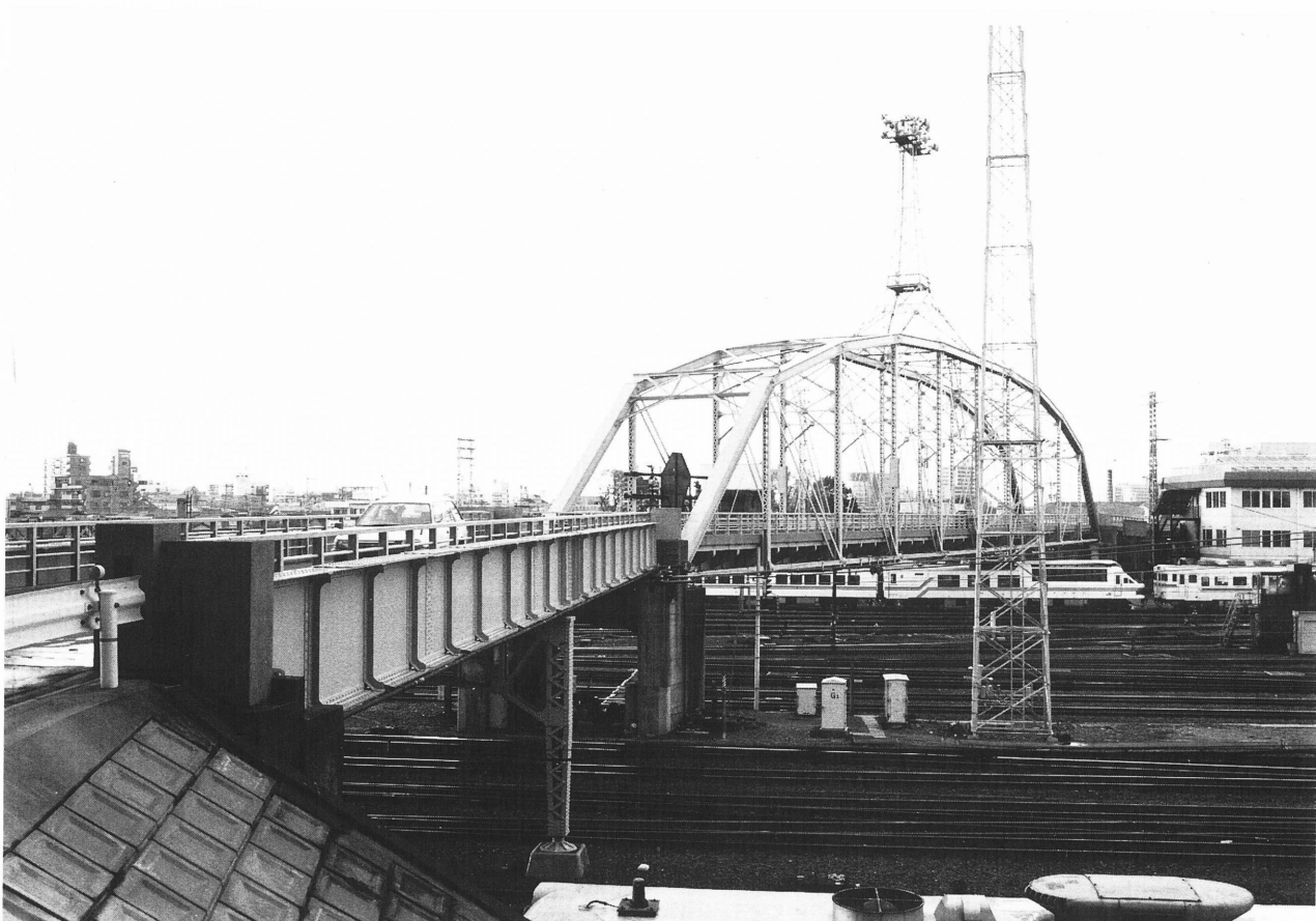
照明塔をのせたトラスとプレートガーダーからなる向野跨線橋。
