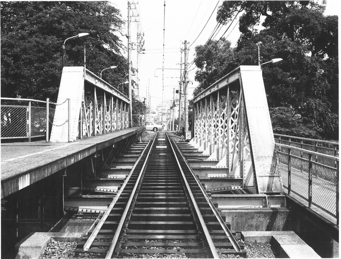
左側にプラットホーム、右側に歩道を載せた石手川橋梁
