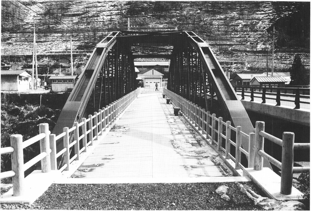
歩道橋となった古河橋
