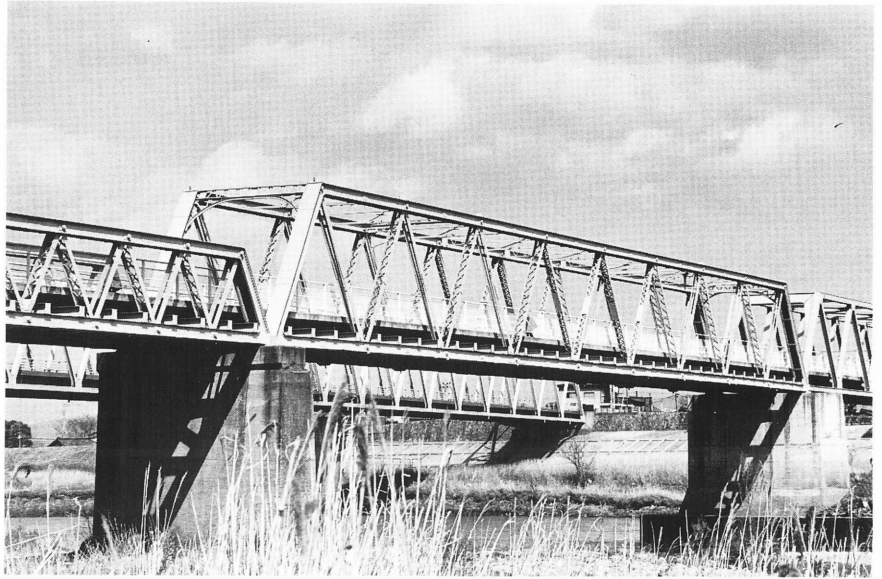
4連目のポニーワーレン改造60mトラス <1986年4月12日, 撮影・いづれも小西純一>
