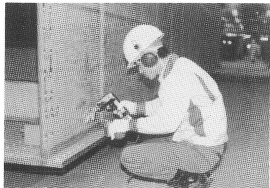
写真9-1 磁粉探傷検査状況
