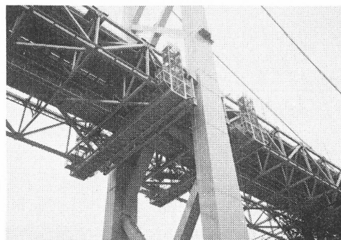
写真－3.2 常設の桁作業車（因島大橋）
