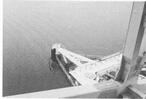
写真－2.11 大島大橋に用いられているロープ式緩衝工
