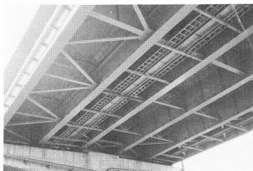
写真－2.1 都市高速道路高架橋の点検通路
