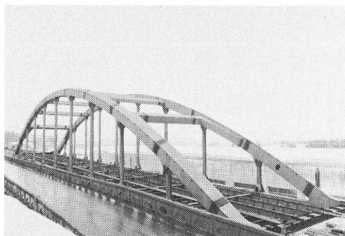
写真-2.19 積雪対策に上弦材の上フランジに傾斜をつけたアーチ橋
