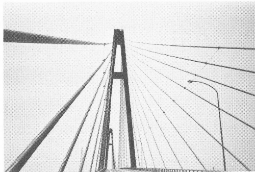
写真-2.15 斜張橋ケーブルに設けた制振ワイヤー
