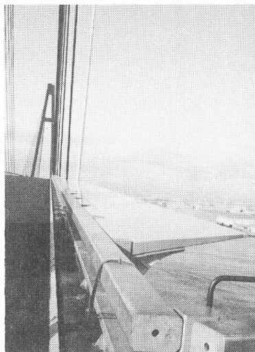
写真-2.12 高欄に設置したフラップ
