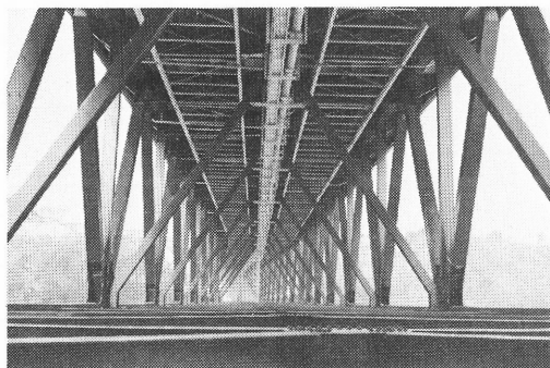
写真－2.3 移動作業車を補完する点検通路
