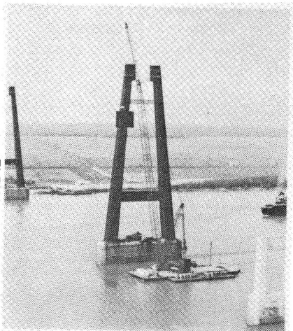
第 15 図 塔の架設および架設用クレーン Fig. 15 Erection of tower and Barge-mounted crane
