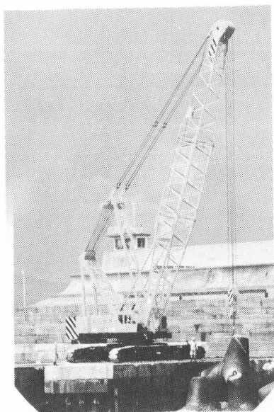
写真 II.8 クローラークレーン
