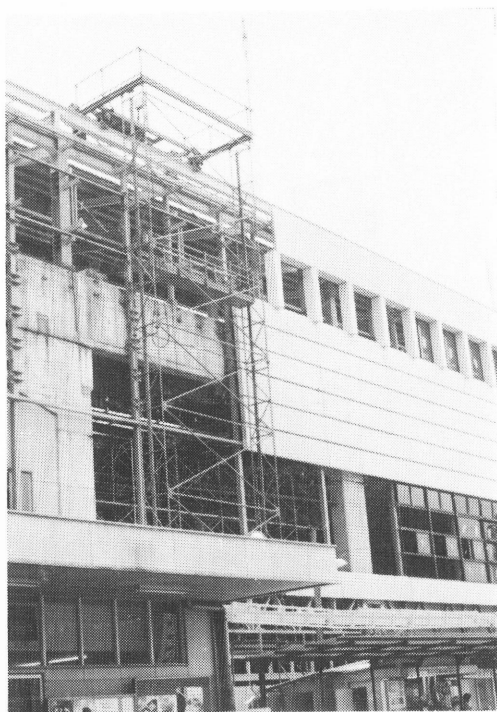
写真 II.11 建設用リフト
