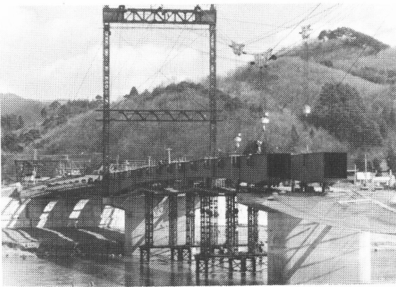
写真 II.5 ケーブルクレーン
