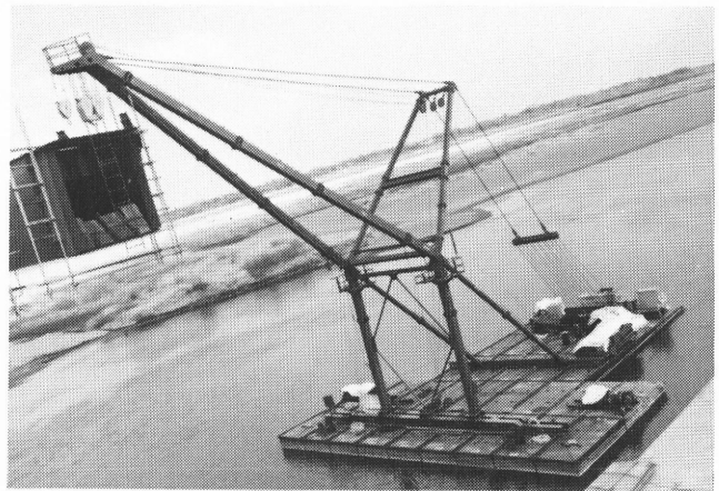
写真 II.10 組立式浮きクレーン
