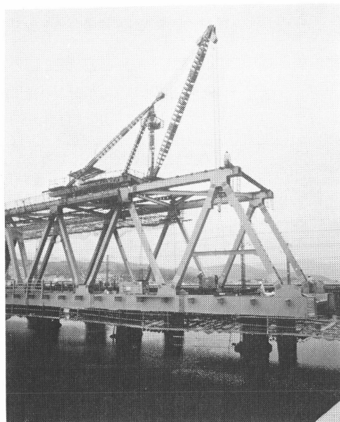
写真 II.1 三脚式ジブクレーン
