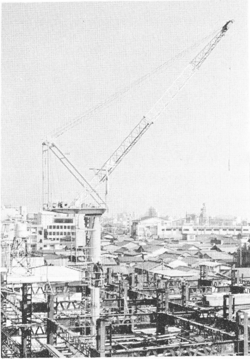
写真 II.3 タワークレーン
