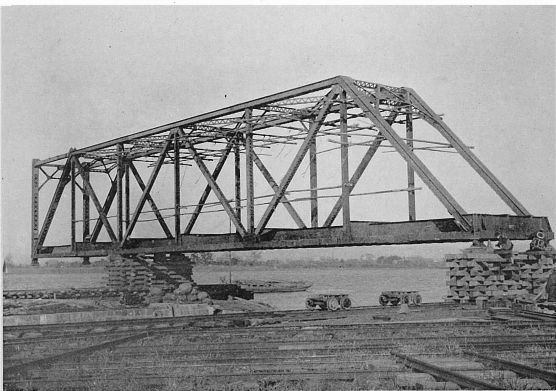
寫真 第二十四 構桁ヲポンツーン積込位置ニ引出ス
