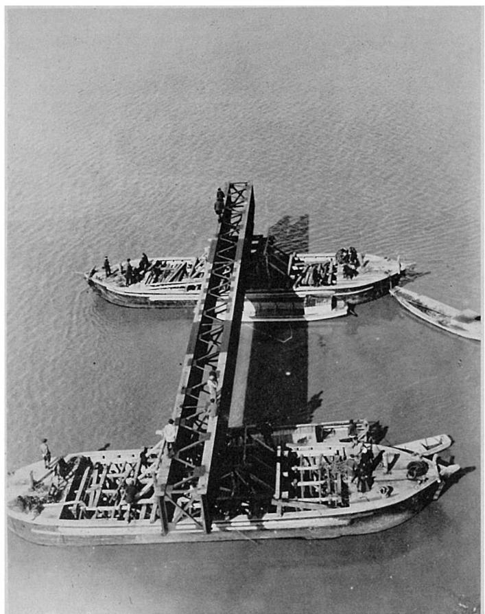
寫真 第十五 鋼桁架設位置曳航中
