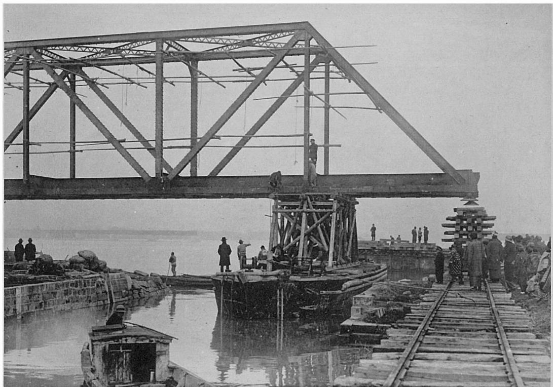
寫真 第二十五 構桁ヲポンツーニテ受ケル
