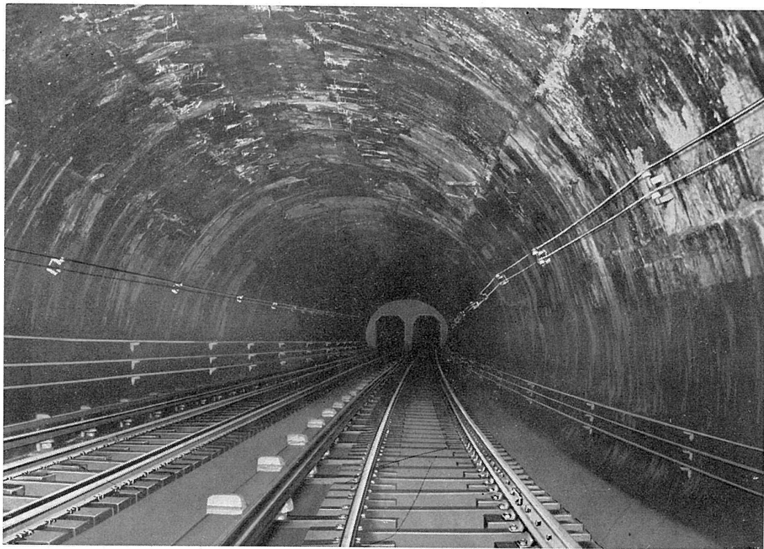
部道隧型拱ル依ニ法工式坑導
