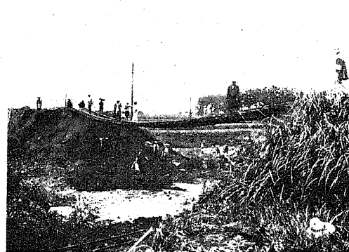
由良・八橋間 255 km 100 m 附近
