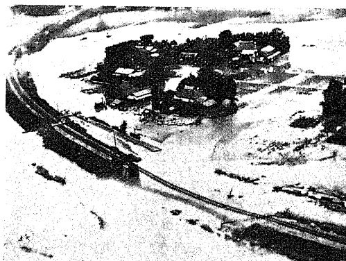
庄原・直江間 378 km 257 m 水行川開渠附近
