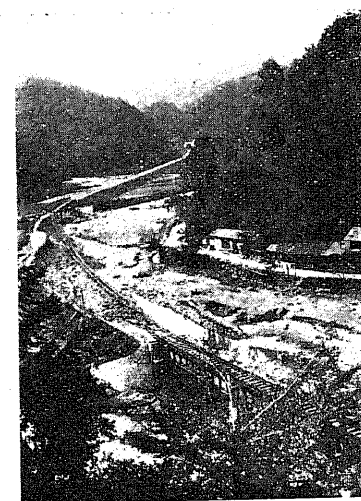
図-25. 月田川に沿ふ線路築堤被害の状況
