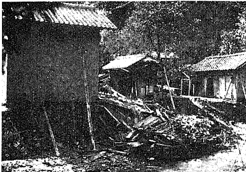
22. 道路橋梁流失
