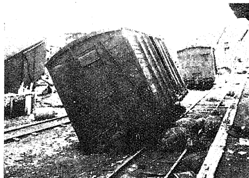
図-44. 本屋前に於ける貨車顛覆状況
