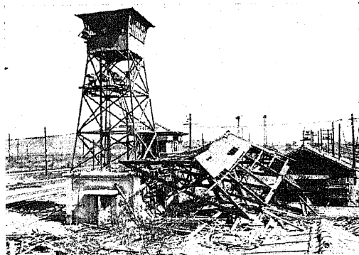
図-69. 吹田操車場本屋倒潰状況
