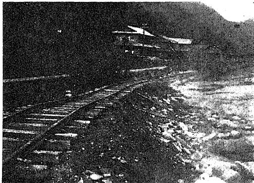
図-27. 線路築堤流失状況
