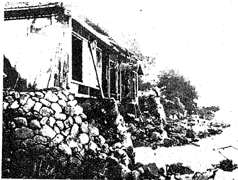
図-7. 釜口村海岸の被害
