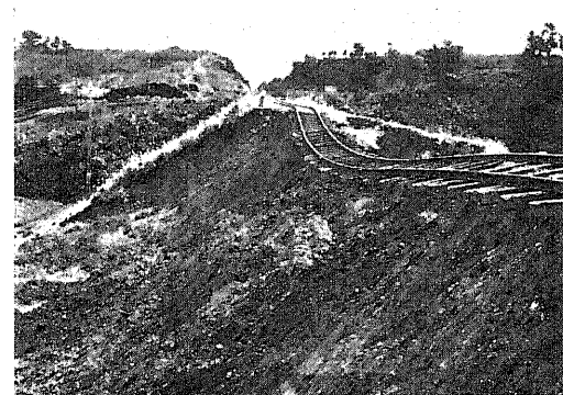
八橋・赤崎間 291 km 080 m 附近
