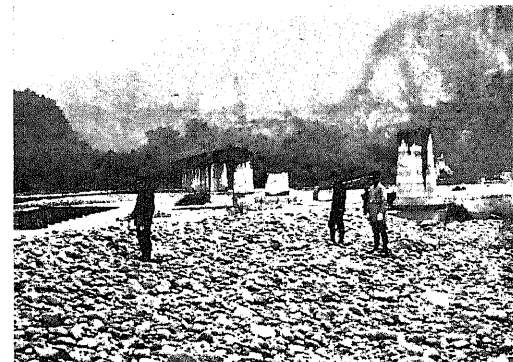
図-35. 第8高梁川橋梁流失状況
