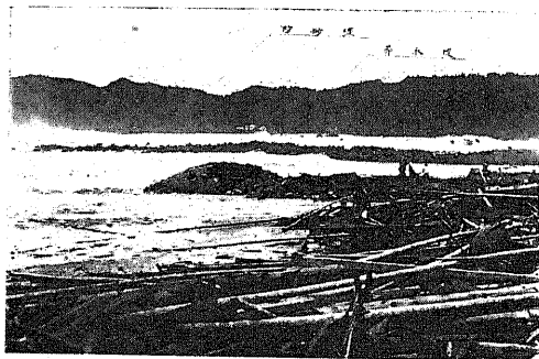
図-10. 牟岐港防砂堤の被害
