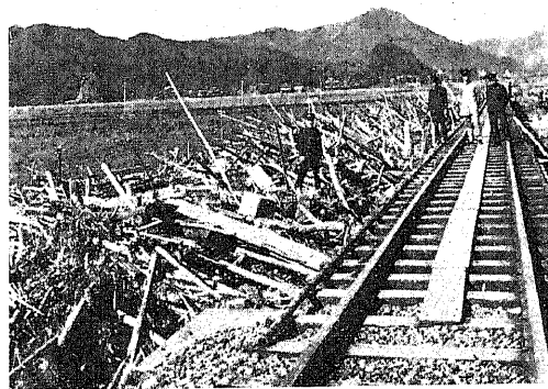
図-8. 岸田川避難橋に流木山積したる状況
