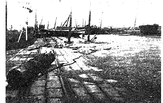
大阪港方より浪速方を望む (昭 9. 9. 21. 撮影)
