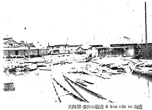
大阪駅・安川口間 6 km 620 m 附近
