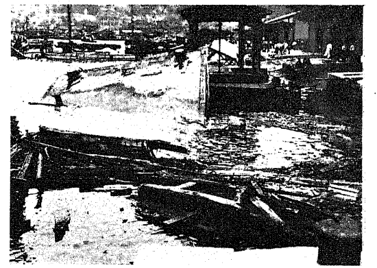
図-8. 浮棧橋の被害 (神戸港内海岸通突堤西側)
