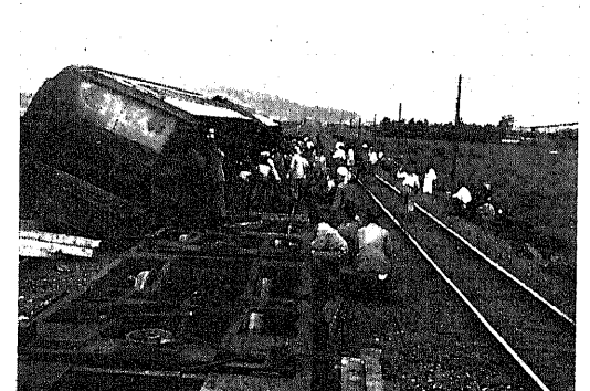
攝津富田驛構内東京起點 537 km 500 m 附近
