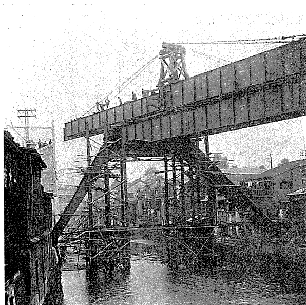
寫眞第五 帆柱式架設(總武線、神田川)
