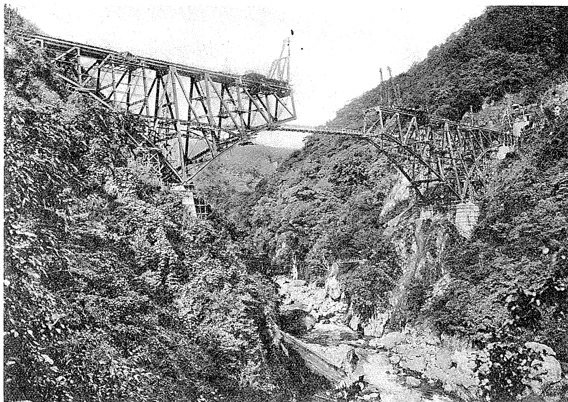
寫眞第十一 拱橋架設(高森線第一白川)
